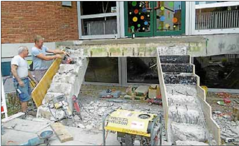
Erneuerung der Eingangstreppe an der Mörikeschule.
