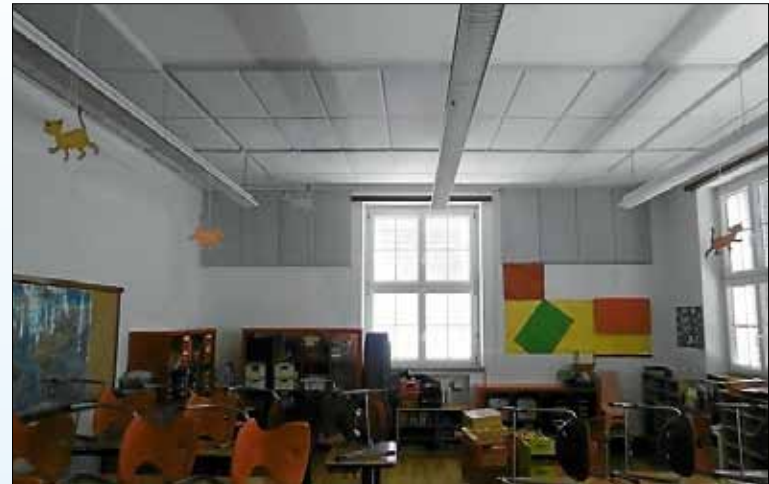
Akustikplatten in Klassenzimmern der Mörikeschule.
