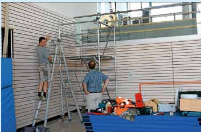
Bürgermeister Otto Ruppener begutachtet das neue Geländer. Die Schreiner des gemeindlichen Bauhofs bringen die Holzverschalung, die bei der Montage des Glasgeländers teilweise entfernt werden musste, wieder an.
