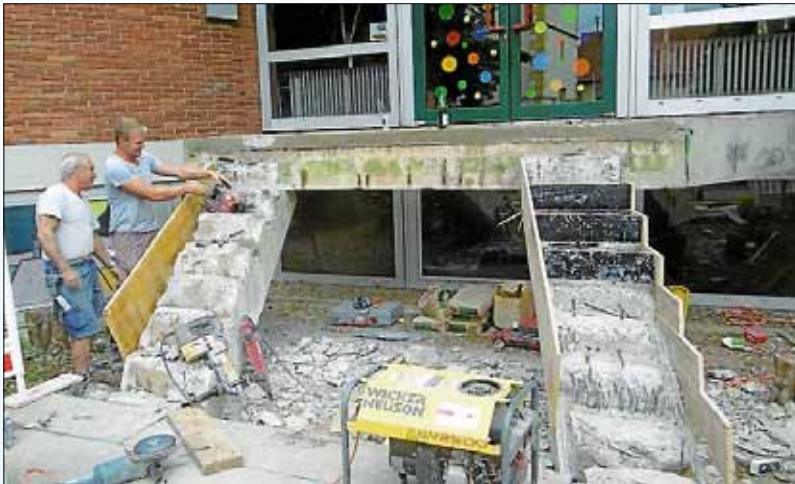
Erneuerung der Eingangstreppe an der Mörikeschule.
