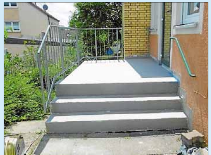
Sanierung der Außentreppe im Goldacker-Kiga.
