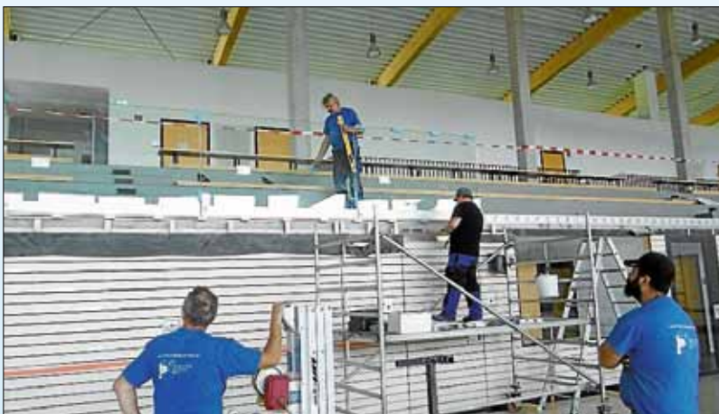
Erneuerung des Geländers Zuschauertribüne Sporthalle Fuchsgrube.
