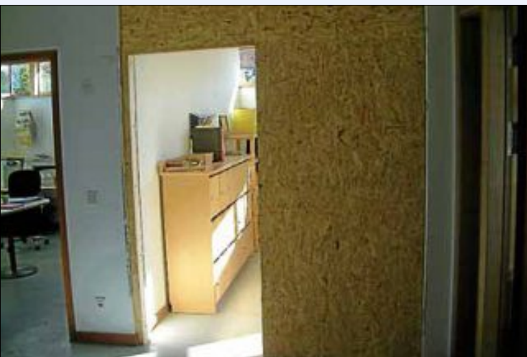
Renovierungsarbeiten im Goldacker-Kindergarten
