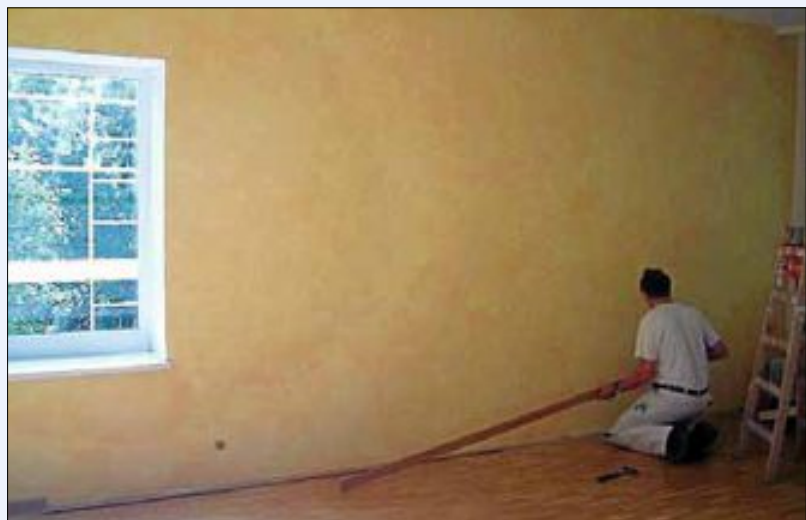
Umbauarbeiten im Kinderhaus Regenbogen
